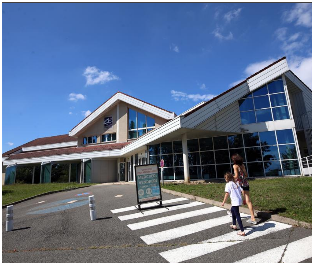
Les élus du CSE de PSA (ex-CE) occupent ce bâtiment de 1 800 m 2 , situé 1 rue Centrale à Sochaux, depuis début janvier 1999. Photo ER/Lionel VADAM
