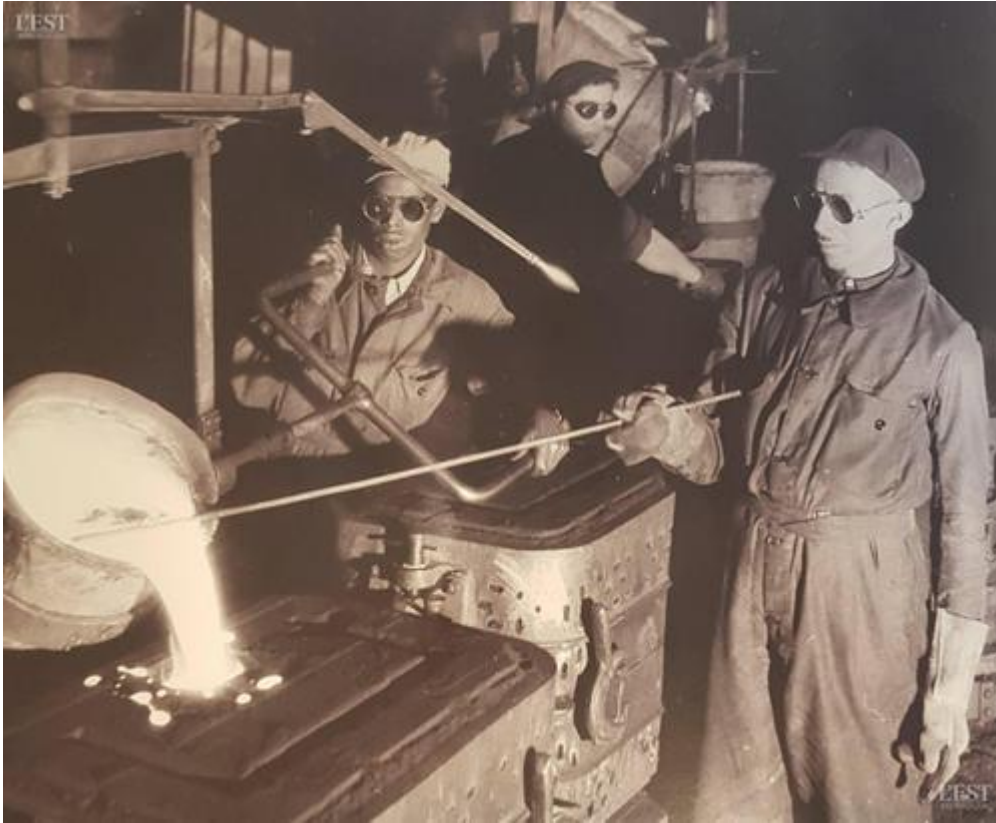
Un travailleur africain s'occupe de la coulée au moule du cylindre de la 203, en 1952. Photo DR
